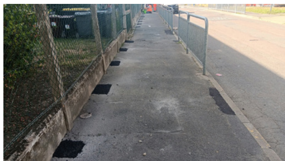
Mise en sécurité d'emplacements de fourreaux dangereux devant l'école La Fontaine.
